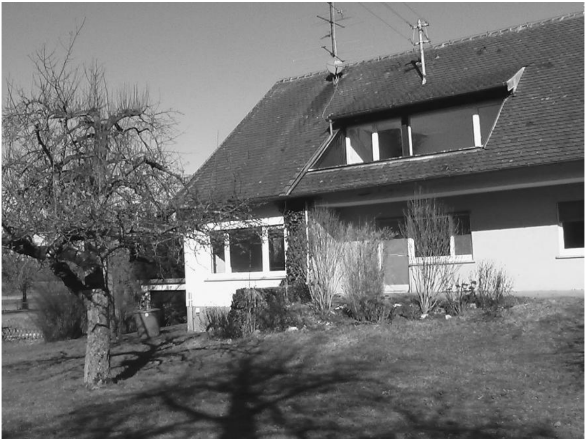
Die Südseite des alten Gebäudes
